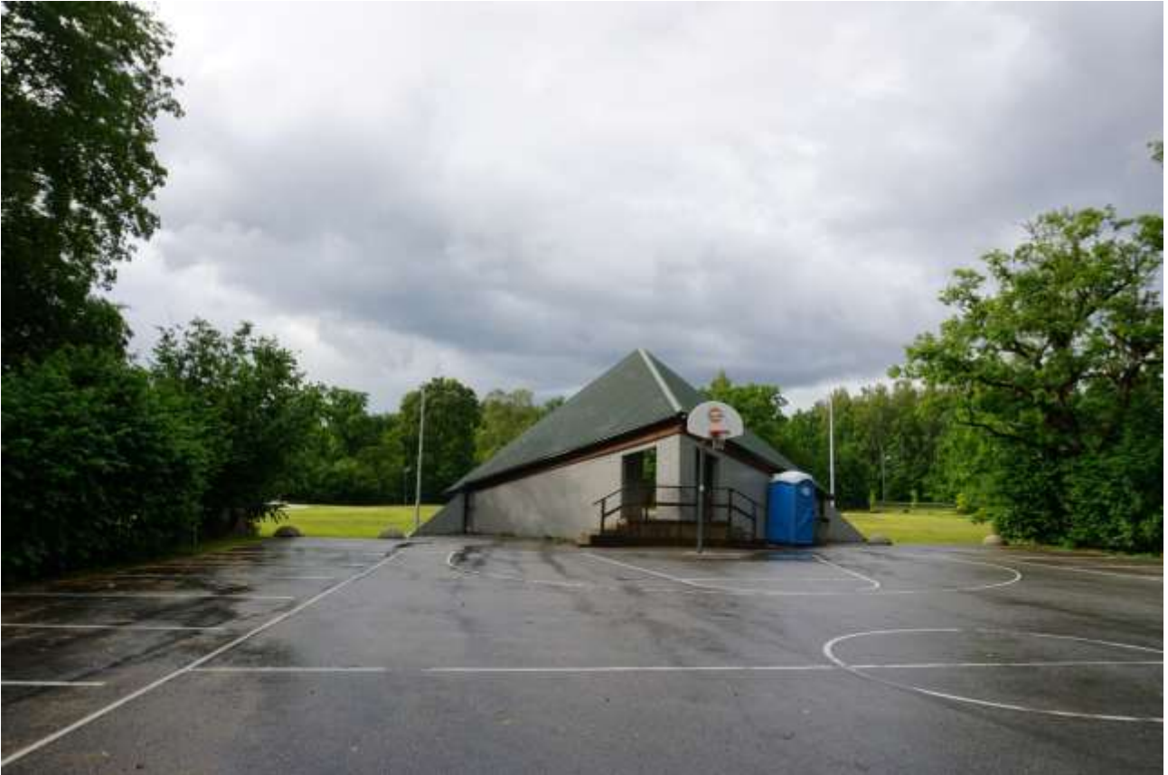
Foto 9. Asfaltkattega korvpalliplats laululava taga. 2019. Foto autor: Laura Andla. 37
