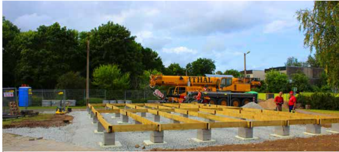
26. august: koht, kuhu moodulkoolimaja paigaldada, on ettevalmistatud, kraana ootab
