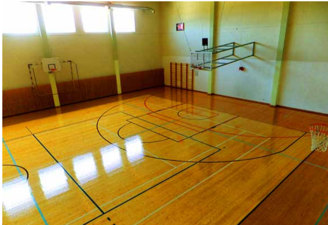
◇ Suvel lihviti kooli võimla puitpõrand ja kaeti õlibaasil lakiga, värviti üle väljakute piirjooned, teostati järelkõlkestuse mõõtmine ning vahetati vahekardina siinid koos rullidega uute vastu. Foto: Tõnu Urva
