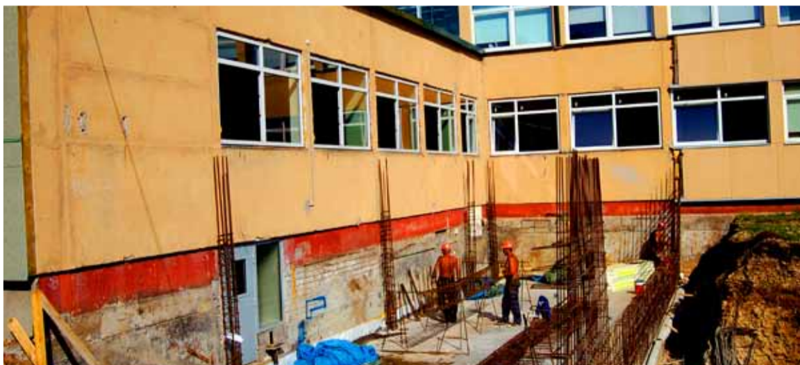
Tõrgeteta sujub söökla laienduse ja huvikeskuse osa, betoonist aluspõrand on juba valmis, algas seinte ehitus
