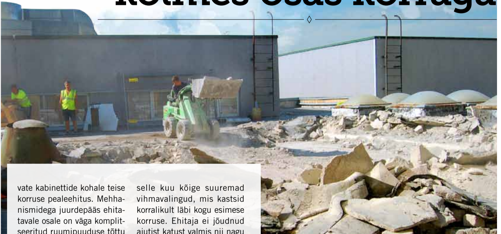
Käib vana katusekatte ja massiivsete soojuskihtide demontaaž tänase fuajee-garderoobi osalt
