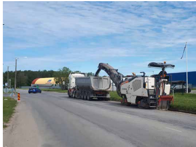
Alanud on Tule tänava katte remont ja jalgteet ehitus
