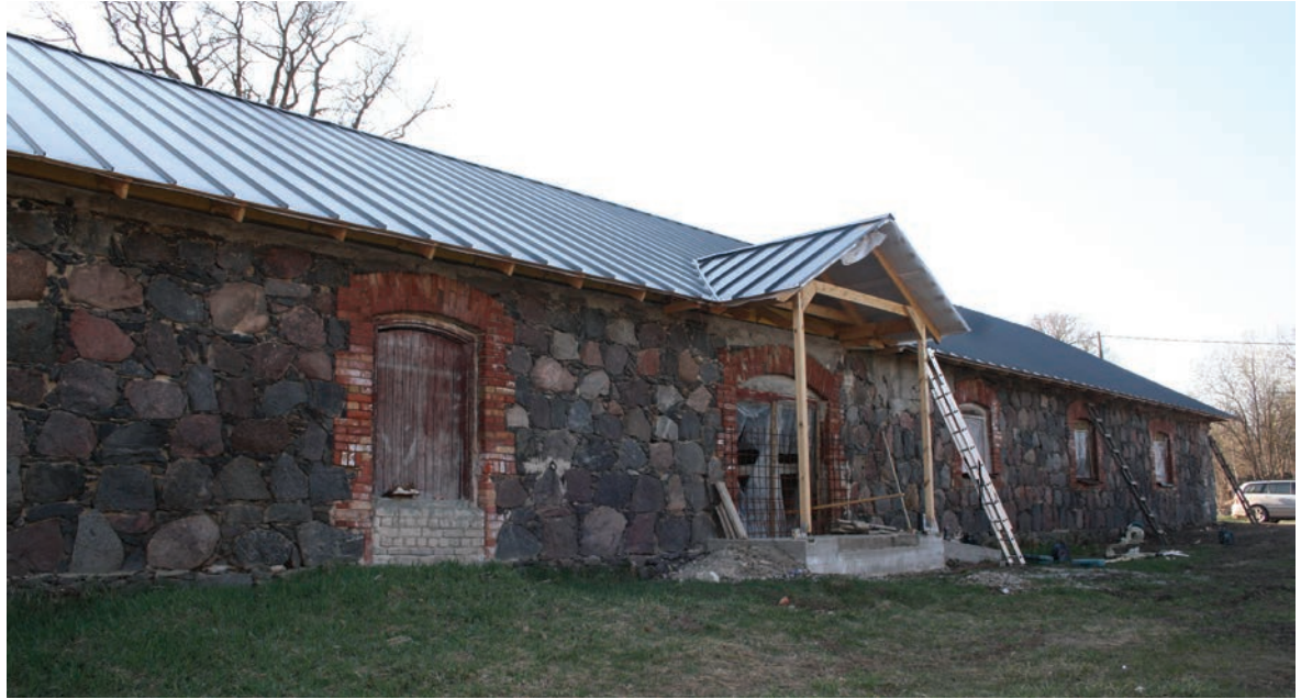
□ Rohkem kui 100-aastane iidsetest maakividest hoone on saanud peal uue katuse, kohe-kohe pannakse ette esimesed 6 uut akent, välja on ehitatud liigendavad vaheseinad ja kogu katusealune karkass.
